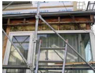
部材や断熱材が腐食した木造住宅
