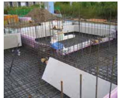
びっしり敷きつめられた基礎配筋
