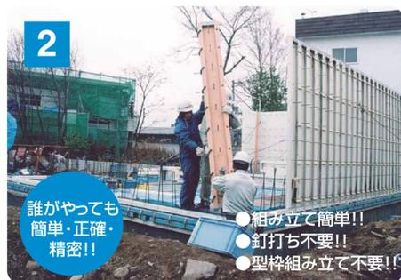
壁の中に鉄筋を組みます
