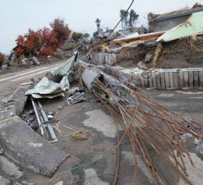
碎けて鉄筋の露出した電柱
