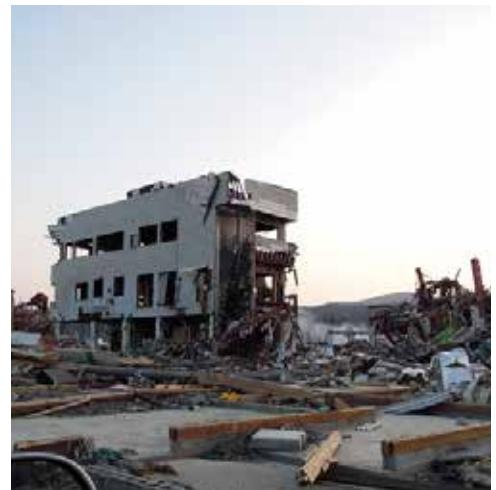
構造の鉄骨がむき出しどなった建物
