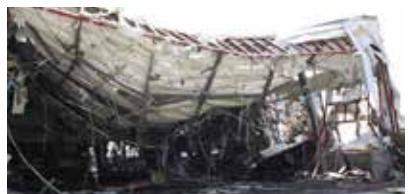
崩壊した鉄骨造の倉庫。
